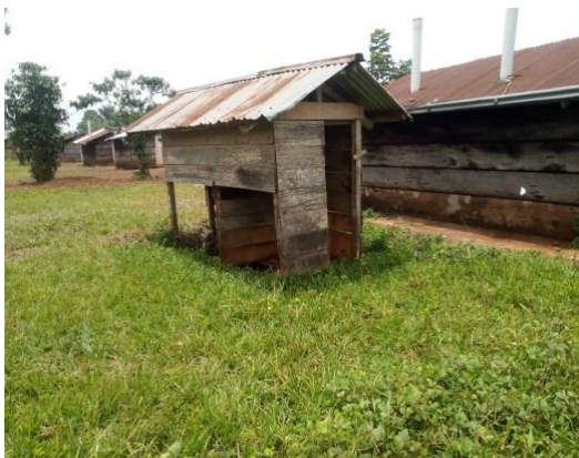
Latrines de l'EP MANGINA
